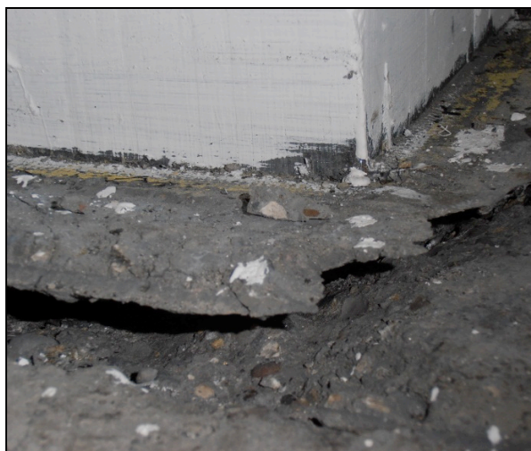
Figura 8. Frattura esterna alla base del pilastro
